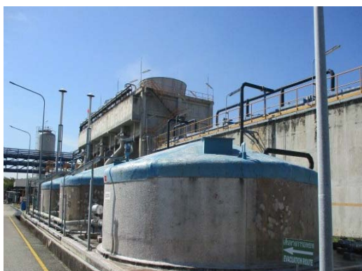
รูปที่ 3.12 หลังคาปิดคลุมบ่อพักน้ำทิ้ง
