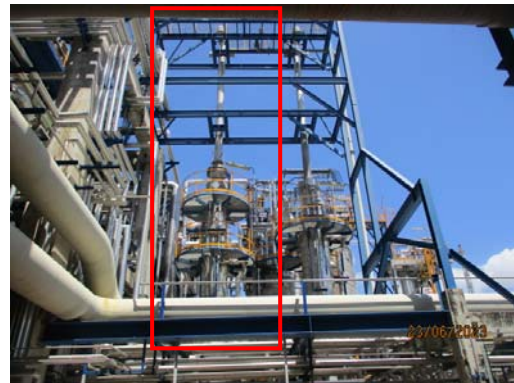
รูปที่ 3.3 ระบบ Acetone Scrubber (D-1904)
