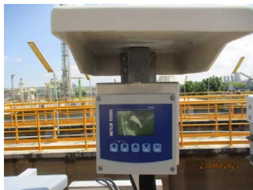
รูปที่ 3.19 ระบบตรวจวัดค่า pH แบบอัตโนมัติ
