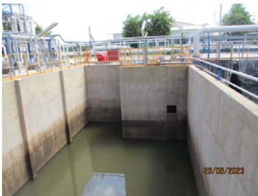
รูปที่ 3.18 บ่อรองรับน้ำฝนปนเปื้อน
