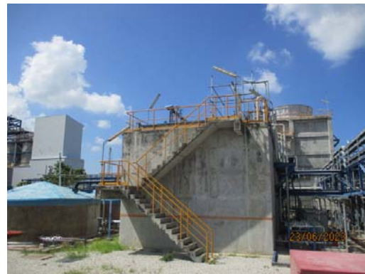
รูปที่ 3.23 ถังเติมอากาศ (AS System (แบบ SBR))
