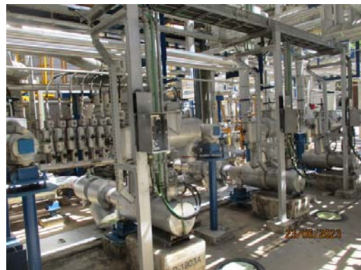
รูปที่ 3.8 เครื่องสูบน้ำสำรอง
