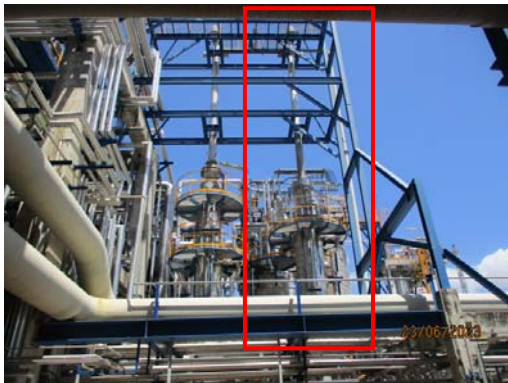
รูปที่ 3.2 ระบบ Phenol Scrubber (D-1903)
