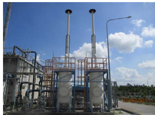
รูปที่ 3.5 ปล่องระบบดูดซับไอระเหย สารอินทรีย์ด้วยถ่านกัมมันต์จากระบบบำบัดน้ำเสีย (D-9201 และ D-9202)
